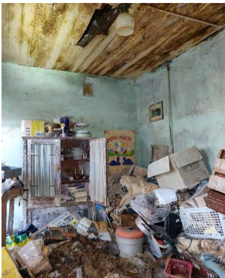
Abb. 2g: Blick in Zimmer neben der Eingangstür und Eingangsbereich mit starkem Schimmelbefall und einstürzender Geschossdecke mit durchhängender mit Wasser gefüllter Folienblase (rechts).
