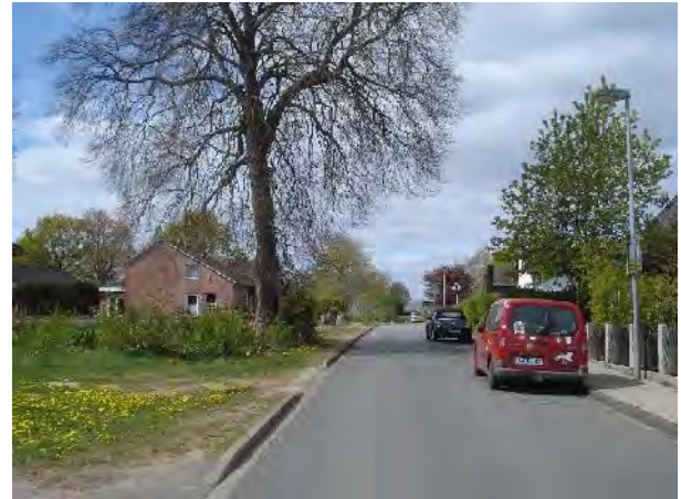
Abb. 3b Ausbaurzustand der „Hauptstraße“ mit dem Gehweg, rechts im Bild
