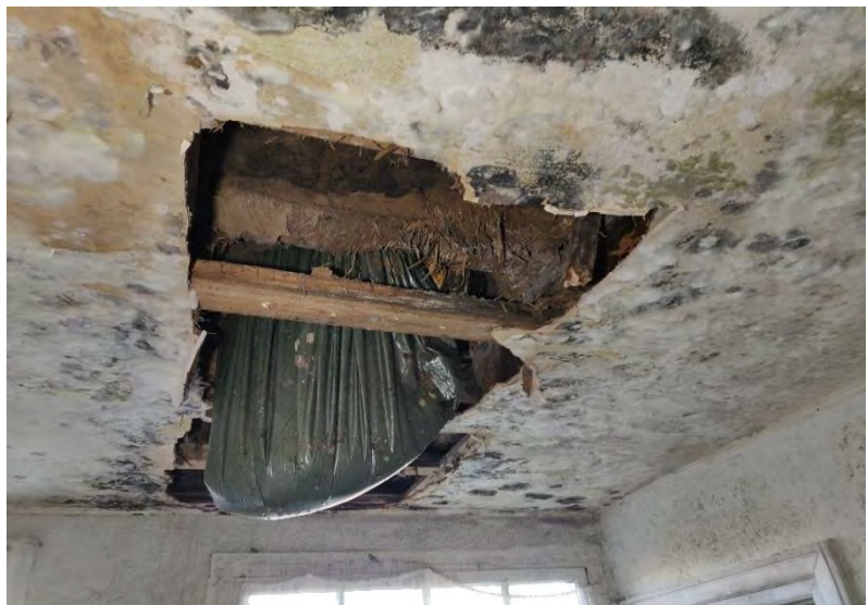
Abb. 2g: Blick in Zimmer neben der Eingangstür und Eingangsbereich mit starkem Schimmelbefall und einstürzender Geschossdecke mit durchhängender mit Wasser gefüllter Folienblase (rechts).
